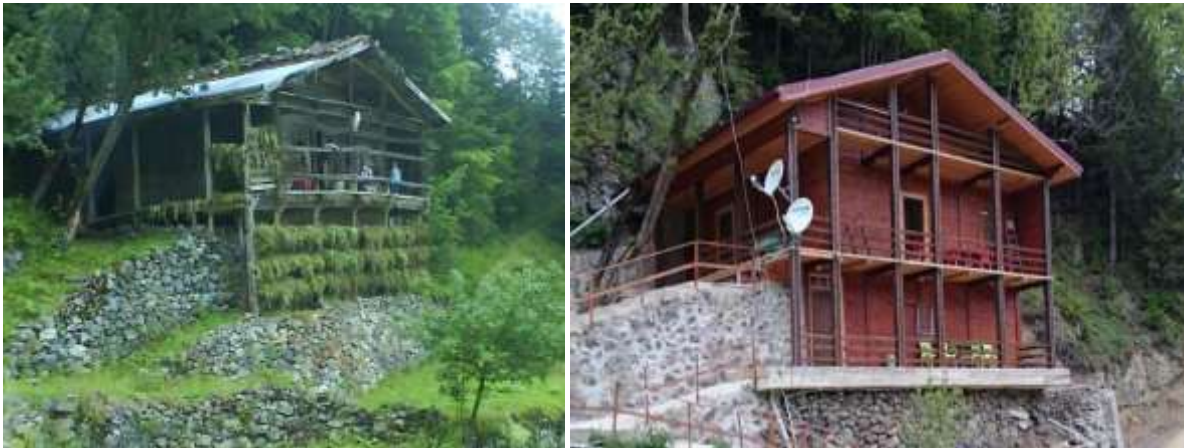
Şekil 6. Tarihi Tescilli Ev'in Restorasyon Öncesi ve Sonrası (Koşon Mevkii)
